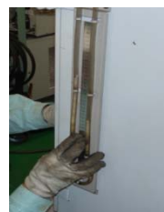
マノメーターの劣化
